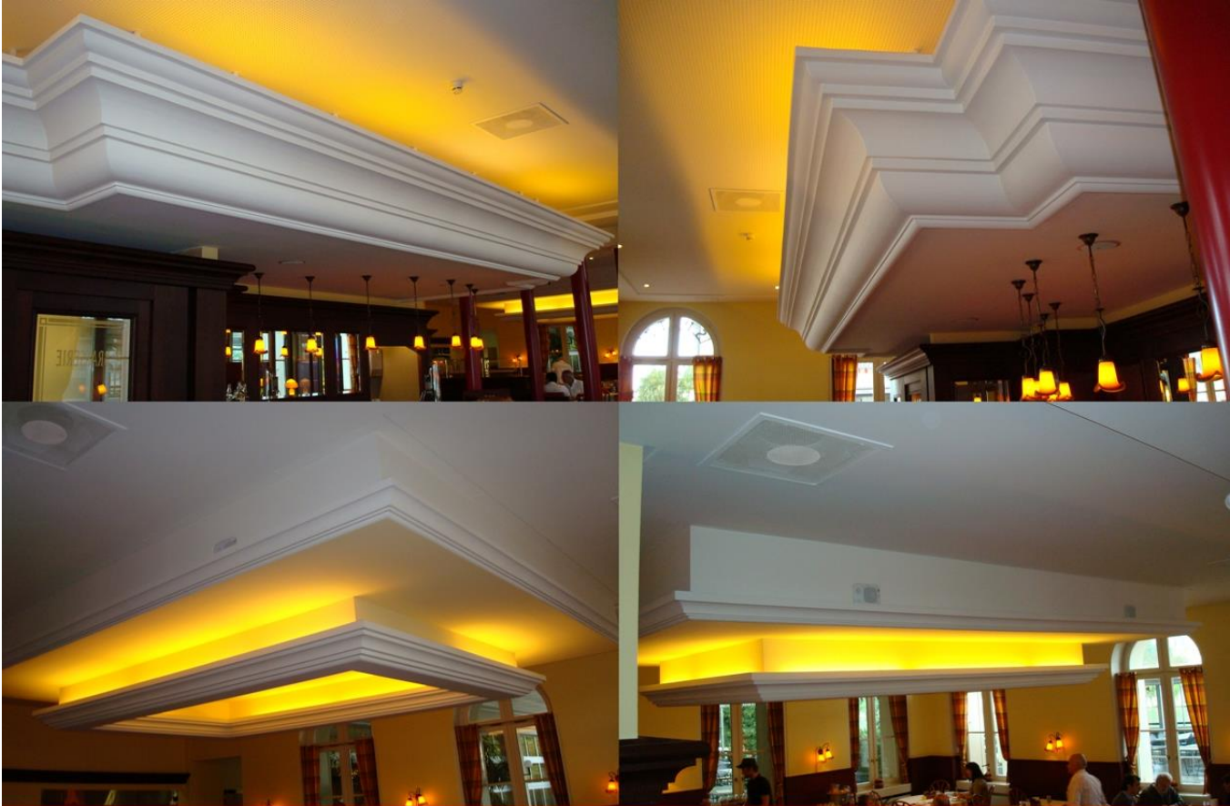
Hotel Merian Basel, Umbau Bar, Restaurant und Reception | Ausgeführte Arbeiten: Gipsarbeiten (Stuckdecken und -friese, Gipsdecken/-segel und Gipslochdecken und Schürzen/Verkleidungen), Metaldecken und spezielle Akustikdecke (Produkt Ecophon) | Ausführung im Jahr 2007
