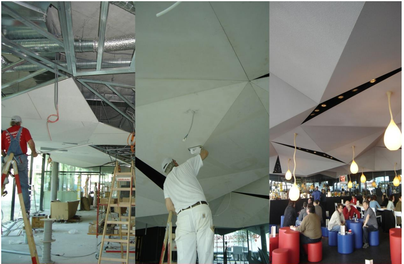
Neubau Geschäftshaus Elsässertor, Basel | Ausgeführte Arbeiten: Triangulierte Akustikdecke (Produkt Cridea Akustik, ehemals Wilhelmi) im Restaurant und Aussenwärmendämmung (Produkt Sto) bei Tiefgarageneinfahrt | Ausführung im Jahr 2005
