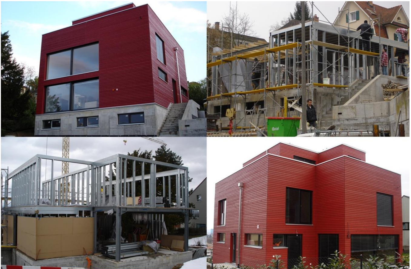
Neubau Einfamilienhaus Hasenrainstrasse 98, Binningen | Ausgeführte Arbeiten: Architektur, Leichtbaukonstruktion, Gipsarbeiten (Gipsständerwände, Gipsdecken, Verputzarbeiten und Türen), Holzfassade, Fenstermontage, Glasfasersternenhimmel, PurSonic unsichtbare Soundanlage | Ausführung im Jahr 2006
