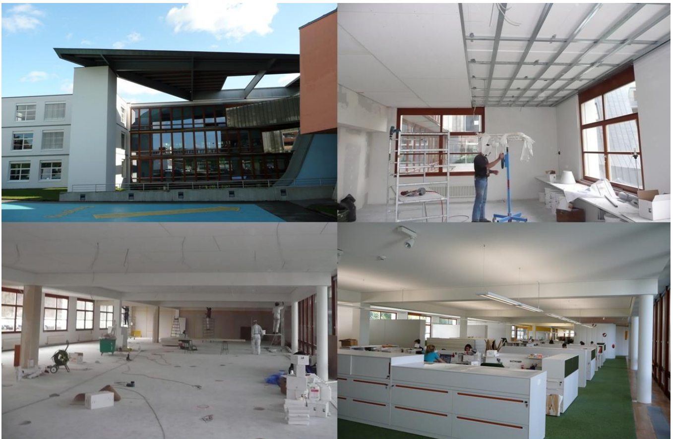
Vitra Birsfelden, Bürotrakt | Ausgeführte Arbeiten: Gipsarbeiten (Leichtbauwände und Verkleidungen), fugenlose Akustikdecke (Produkt Cridea Alvaro, ehemals Wilhelmi) | Ausführung im Jahr 2008
