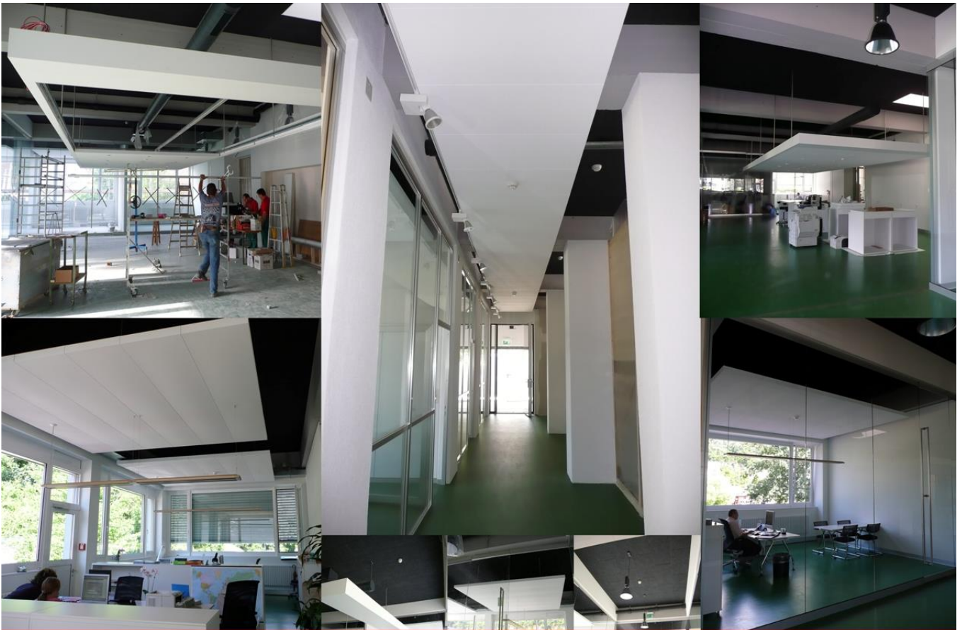
Ricola Laufen | Ausgeführte Arbeiten: Gipsarbeiten (Leichtbauwände, Verkleidungen, Brüstungen, Schürzen), Akustikdecken (Produkt Heraklith) und Akustiksegel (Produkt Cridea Akustik, ehemals Wilhelmi), Metaldecken, Verglasungen, Brandschutz und Kellerdeckenisolationen | Ausführung im Jahr 2008
